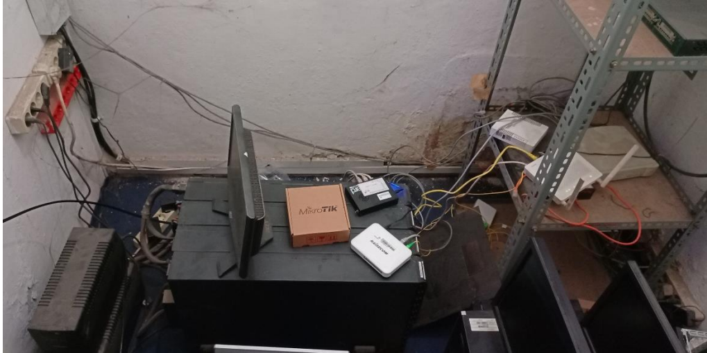
Gambar 27. Ruang Server (Sumber: Penulis, 2021)
