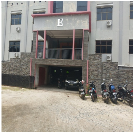
Gambar 2. off street parking di gedung E. (sumber: dokumentasi lapangan, 2019)
