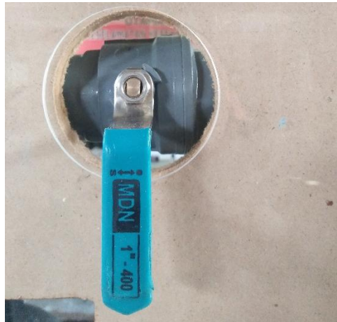
Gambar 3.6 Katup/valve (Sumber: Dokumentasi Sendiri)
