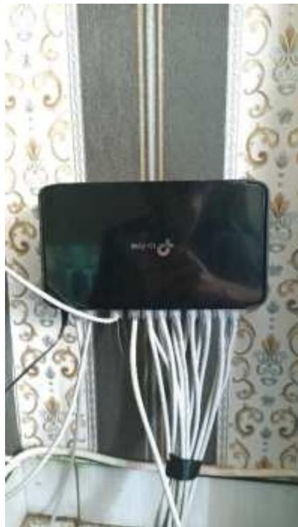
Gambar 28. Switch Hub Tp-link 24 Port (sumber: Penulis, 2023).
