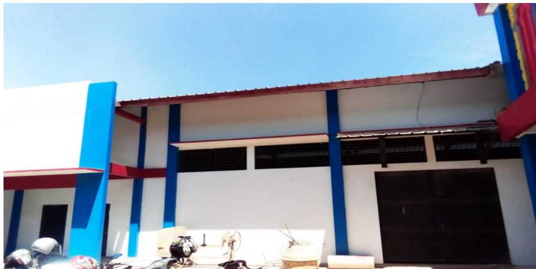
Gambar 11. Laboratorium Mekanika Tanah Fakultas Teknik Universitas Muhammadiyah Metro Kampus 2 (Sumber : Indra Prabowo, 2022)
