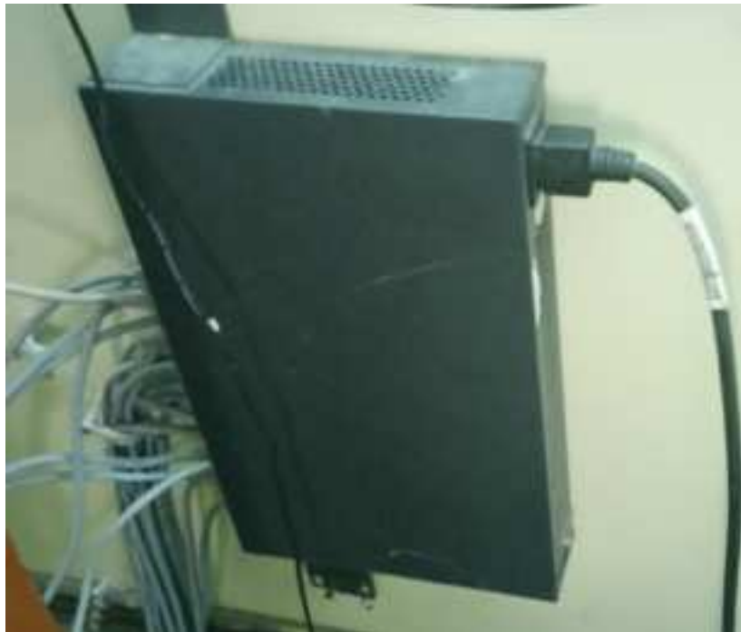
Gambar 34. Hub TP-Link TL-SF1024D 24-port . (Sumber: Penulis, 2023).
