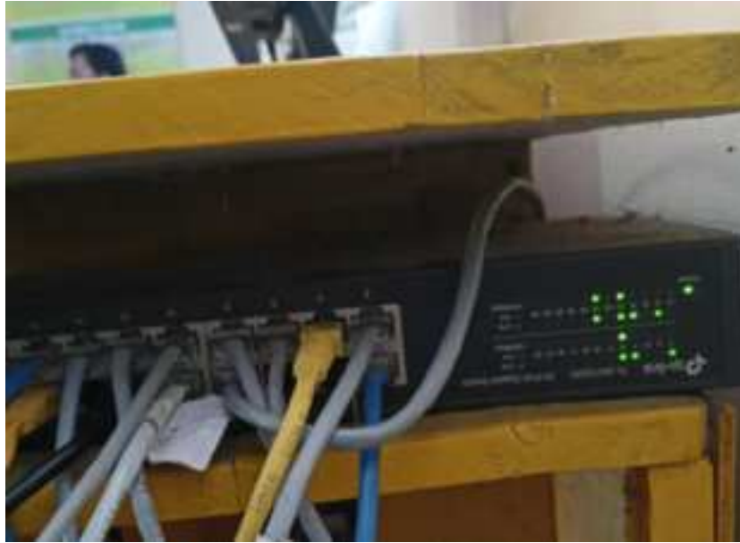
Gambar 33. Hub TP-Link TL-SF1024D 24-port . (Sumber: Penulis, 2023).
