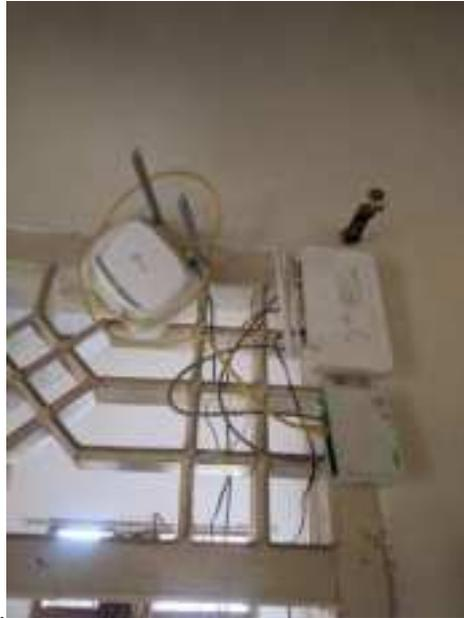
Gambar 37. Router ZTE modem Gpon ONT ZXHN F609 Selatan (Sumber: Penulis,2023).
