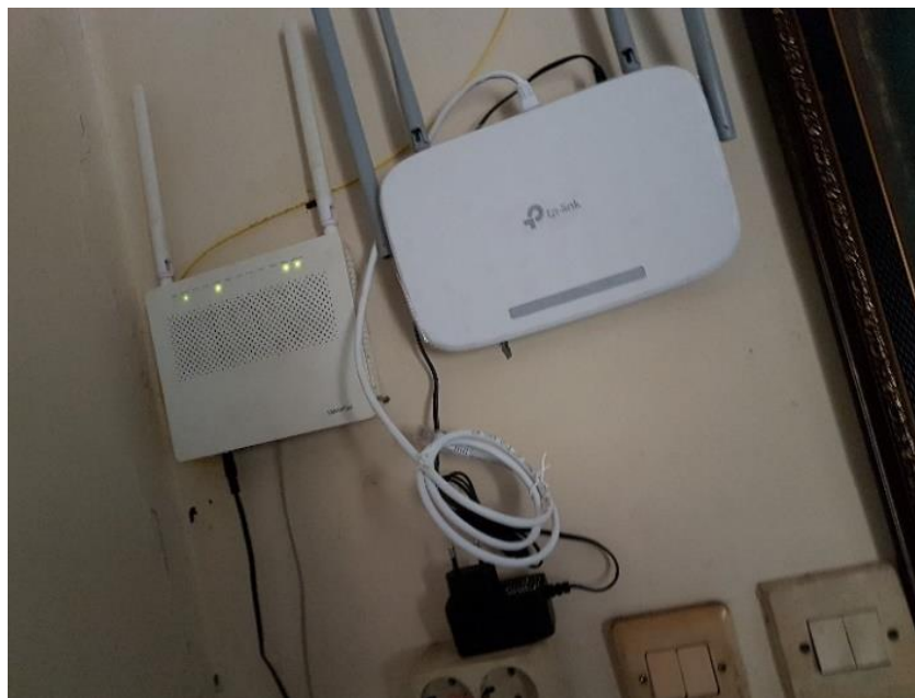
Gambar 40. Ruang Server (Sumber: Penulis, 2022)
