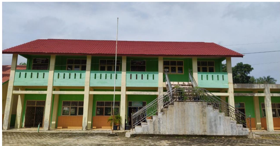
Gambar 26. Gedung Sekolah SMK Islam Roudhotul Falah
