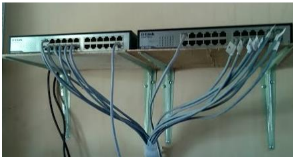
Gambar 44. Switch D-Link DGS-1024C 24 Port (Sumber: Penulis, 2021)
