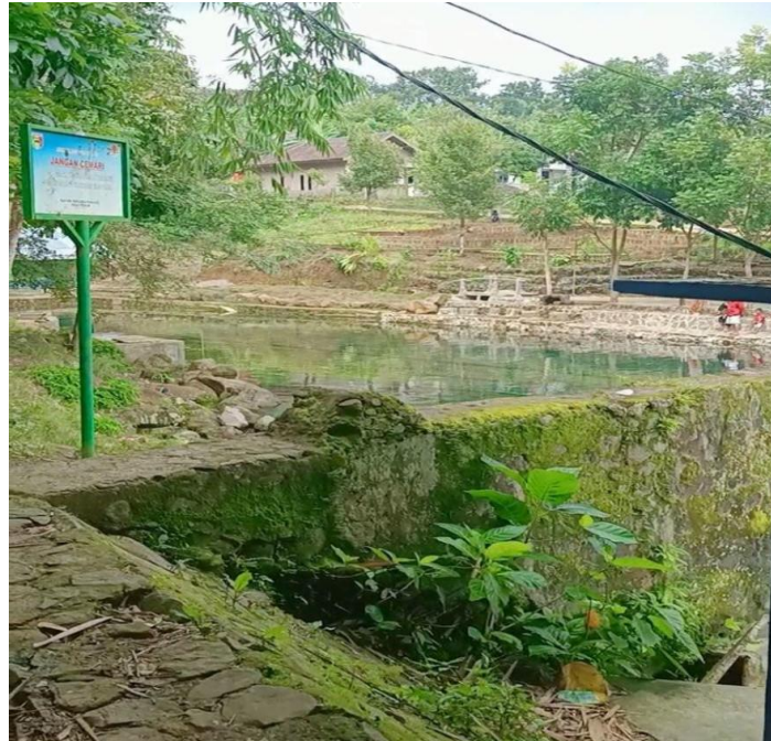
Gambar 13. Dam Margo Tirto. (Diambil pada saat wawancara langsung. Gisting, 07 Februari 2022)
